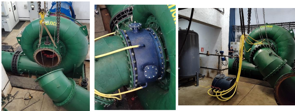
Instalarea sistemului automatizat i-Turb
