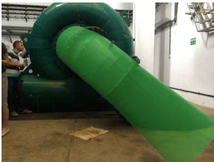
Figura 12. Suprapunerea geometriei 3D peste aspiratorul real al turbinei (fig. 12).
