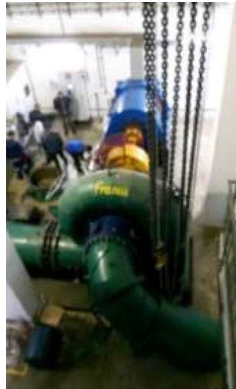
b) Vedere de sus a turbinei cu modelul demonstrator montat
