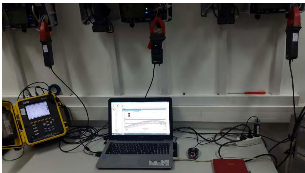
Fig. 3. Standul de testare realizat pentru achiziția indicatorilor de calitate a energiei electrice generată în cadrul CEF.
