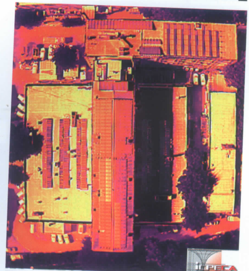
Imagine din dronă, în infraroșu, a sistemelor fotovoltaice instalate pe acoperișul ICPE-CA
