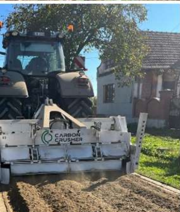
Colaj foto: Dispozitiv de concasare cu dinți speciali pentru zdrobirea materialului existent până la granulația specificată
