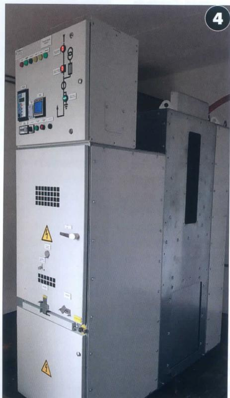
Cellula de măsură de 10kV, în sarcină, la probele finale de punere în funcție
