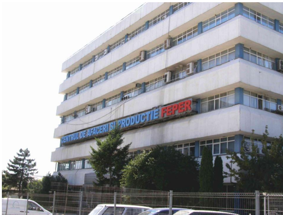
FEPER – Fabrica de Echipamente Periferice, bd Dimitrie Pompei nr 8 sector. 2. Clădirea e cea inițială, însă firma este cea actuală.
